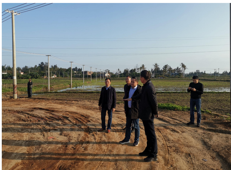
（图：检查自筹资金项目现场清理情况）
