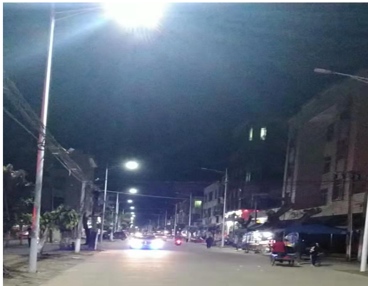
（图：检查镇主干道路灯安装情况）
