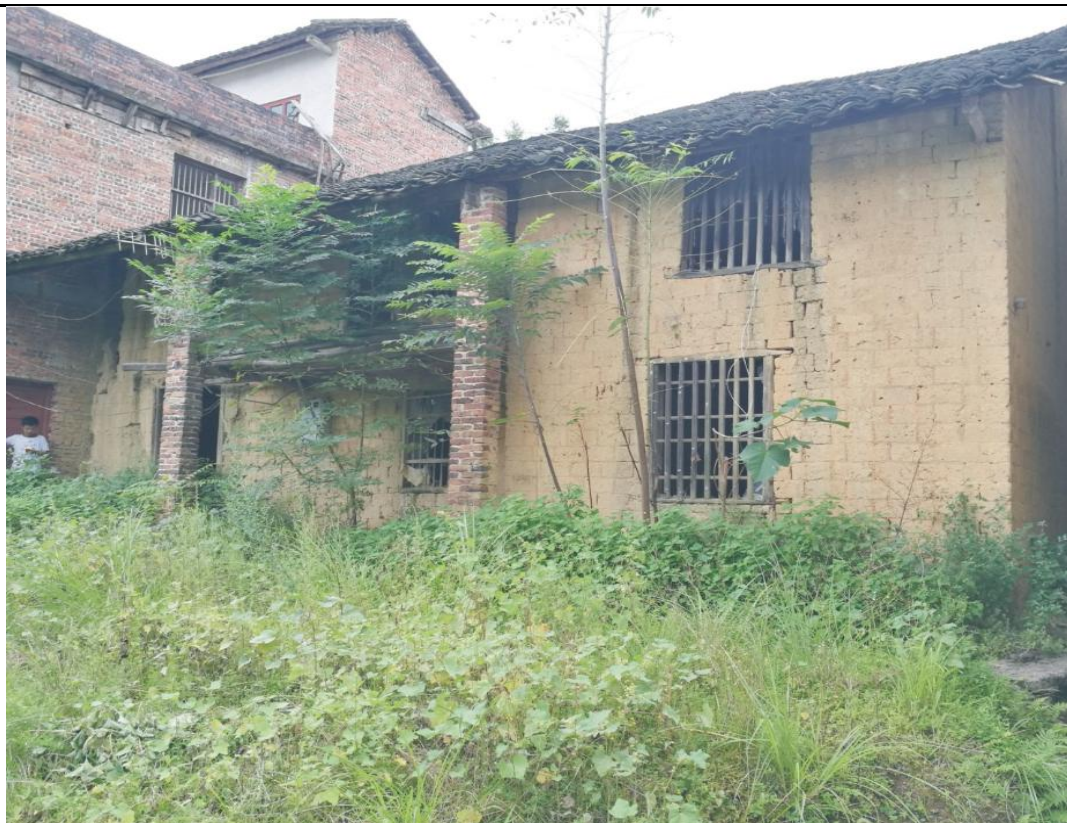
图 6-2-2 南胜村拆旧地块现场影像
