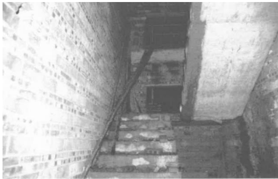
一楼通往二楼的楼梯
