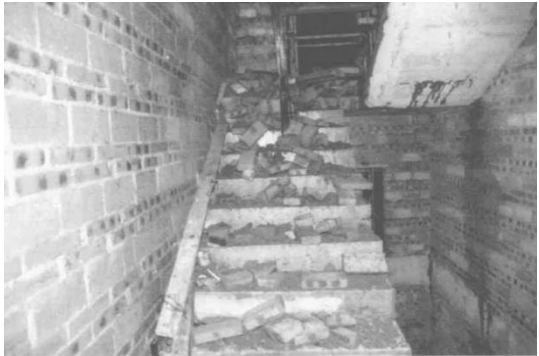
二楼通往三楼的楼梯
