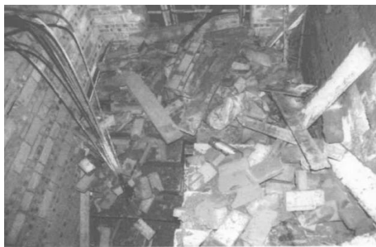
二楼通往三楼楼梯转台及楼梯上遗留的红砖堆和水泥梁柱条
