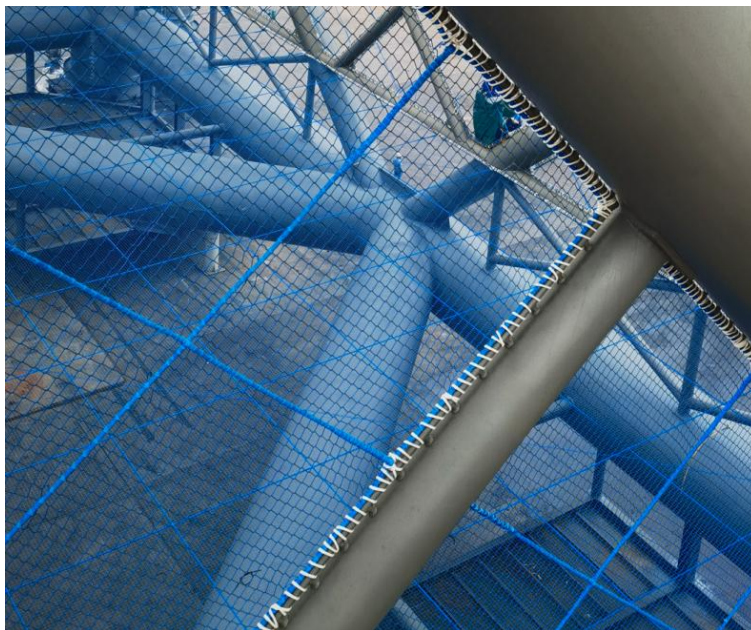
图 1.7.4-4 降低绑扎管尺寸，去掉封堵绳
