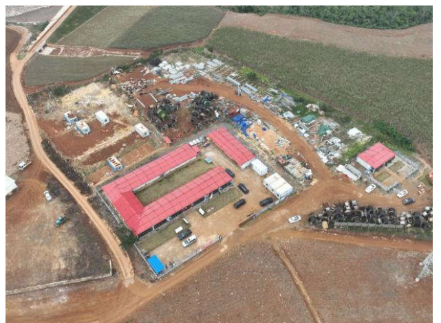
图 24 施工营造区现状
