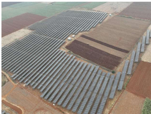
图 6 航拍光伏阵列区现状
