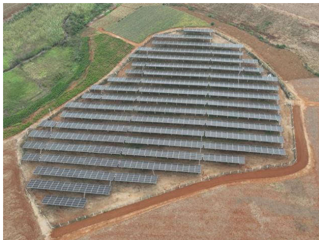
图 4 航拍光伏阵列区现状
