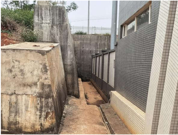
图 19 升压站场外排水沟
