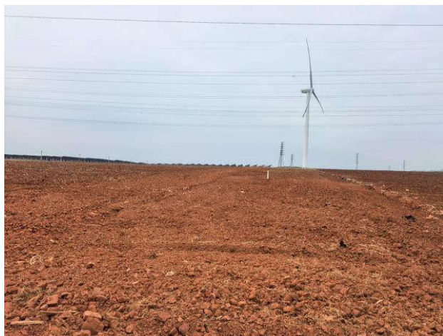
图 8 电缆线路区电缆沟复耕
