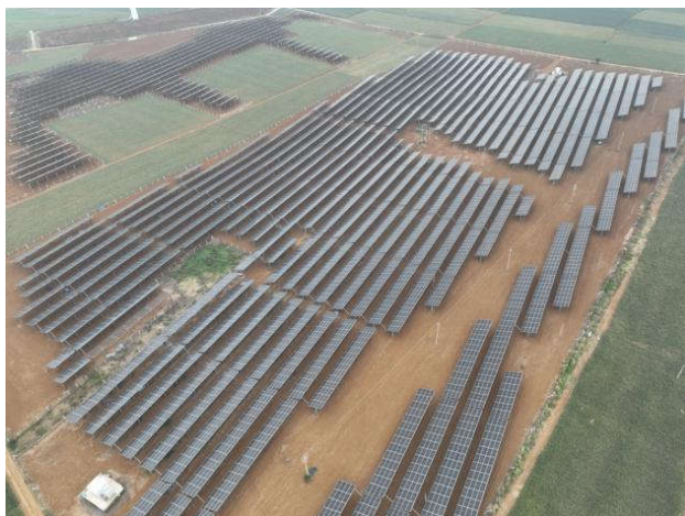
图 1 航拍光伏阵列区现状
