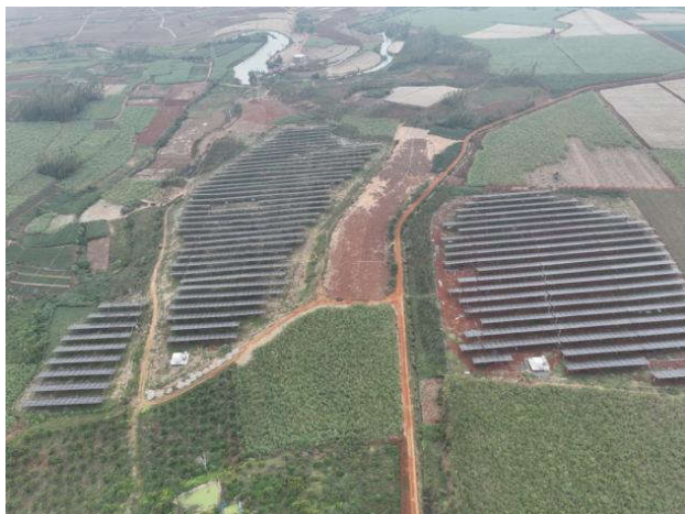
图 3 航拍光伏阵列区现状
