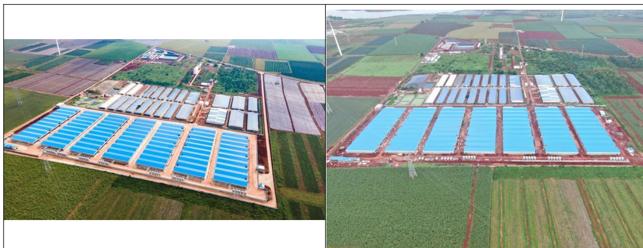
项目区（项目区无人机拍摄影像图）
