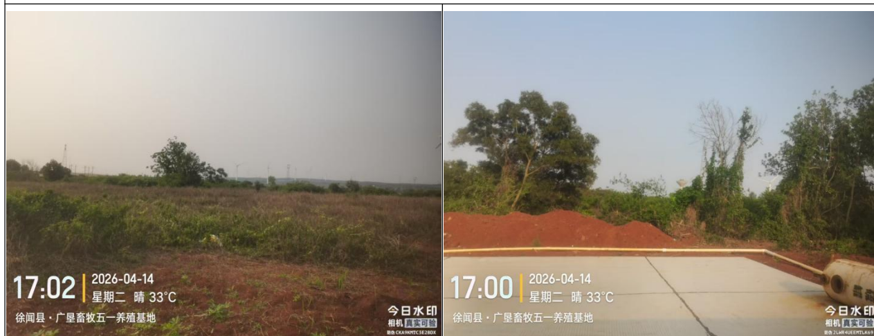
播撒草籽（预流绿化区和施工营造区的绿化照片）
