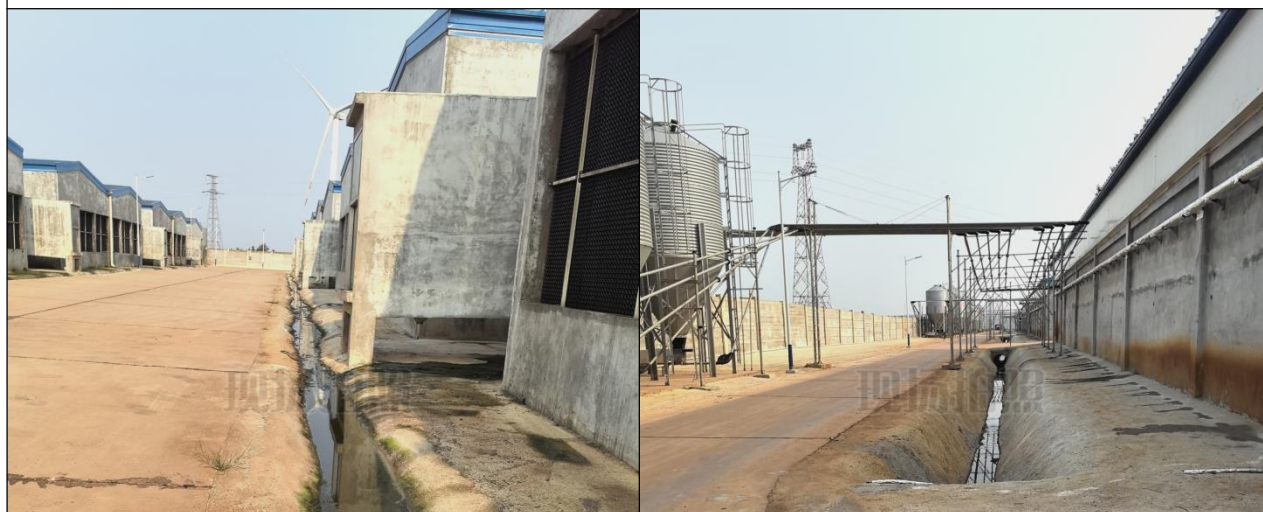
排水沟（建（构）筑物区永久保留的排水沟）
