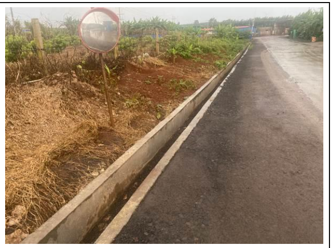
道路区排水沟
