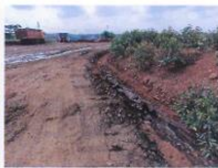
完善项目区内排水
