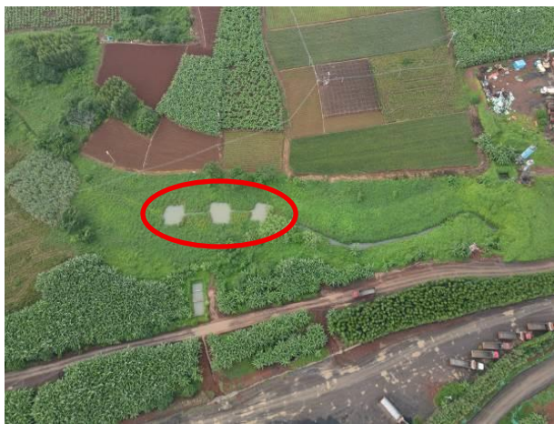
露天采场区沉沙池
