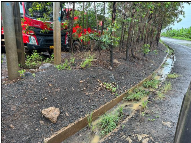
道路区排水沟
