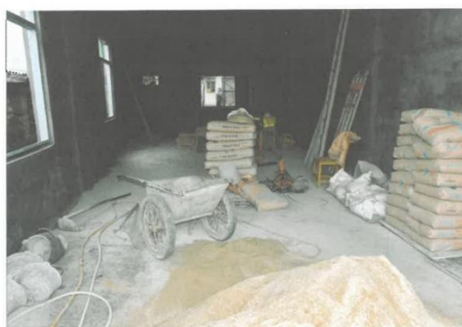
蔡胜在建楼房一楼内的现场状况
