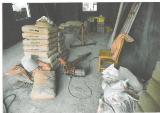
蔡胜在建楼房一楼内遗留的吊机和三脚架
