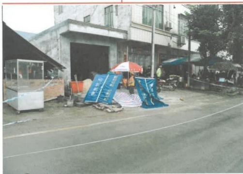
曲界镇光明路蔡胜在建楼房
