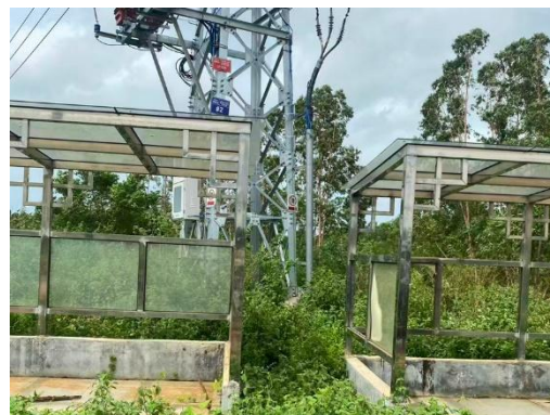
塔基植被恢复
