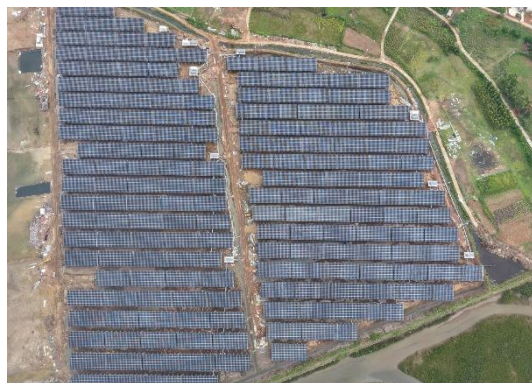
无人机航拍（施工期间）
