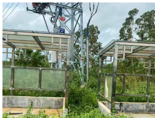
塔基植被恢复
