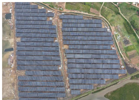
无人机航拍（施工期间）
