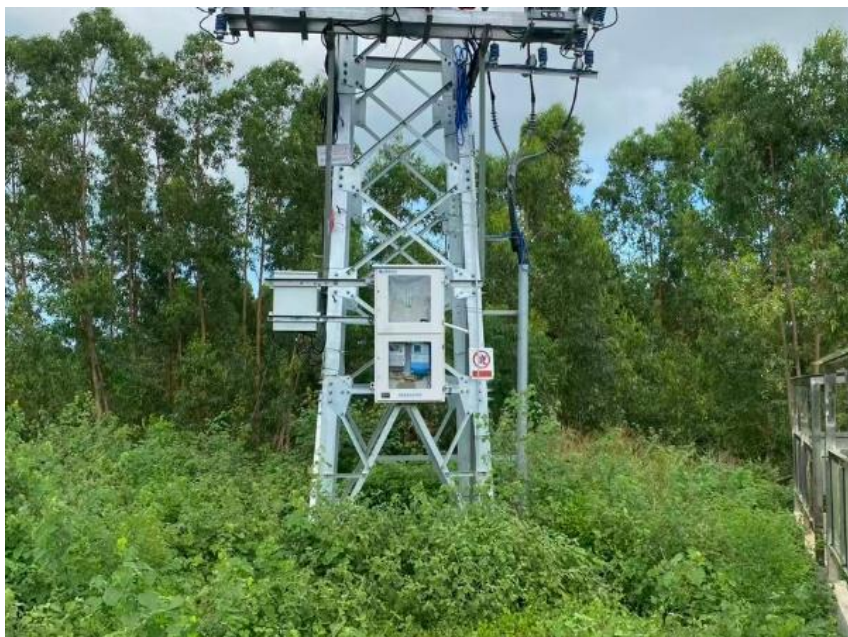
塔基撒播草籽
