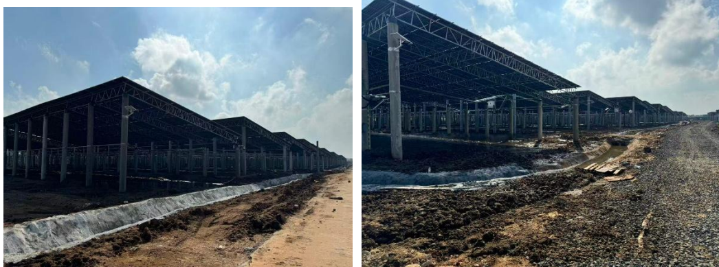
排水沟、排水管
