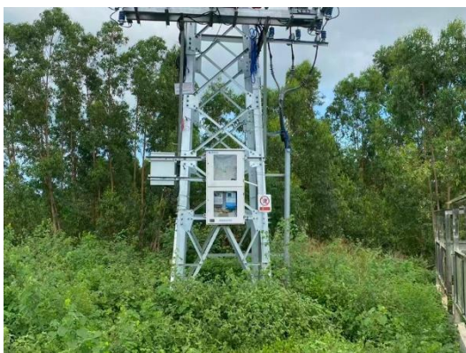
塔基撒播草籽
