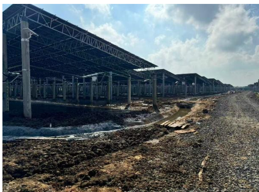
光伏厂区、排水沟、检修道路
