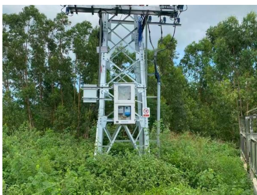
塔基撒播草籽
