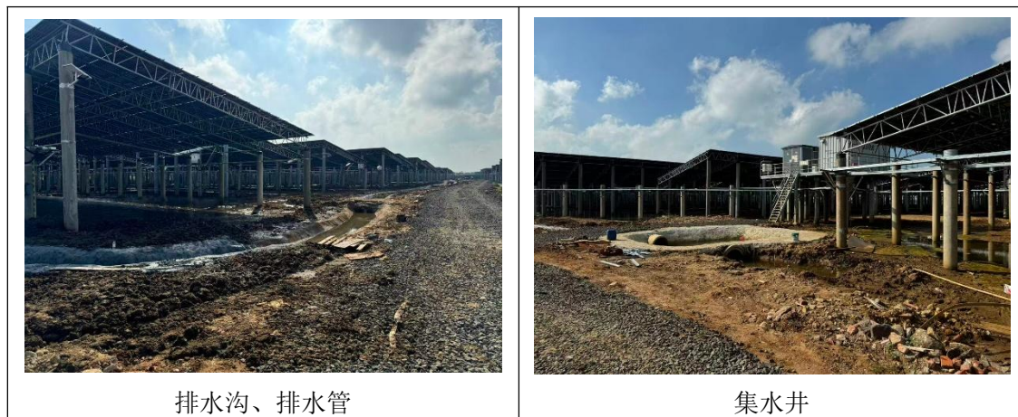
图 4-1 工程措施现场照片
