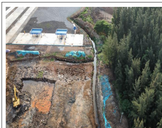
北侧排水沟形成及临时覆盖
