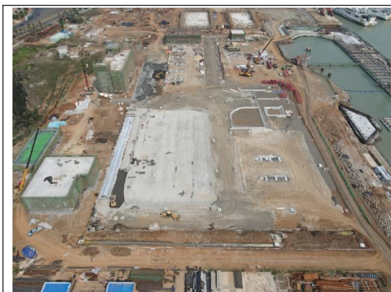
陆域工程及堤防码头区现状
