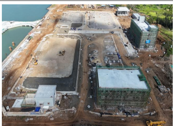
陆域工程建筑物施工进度
