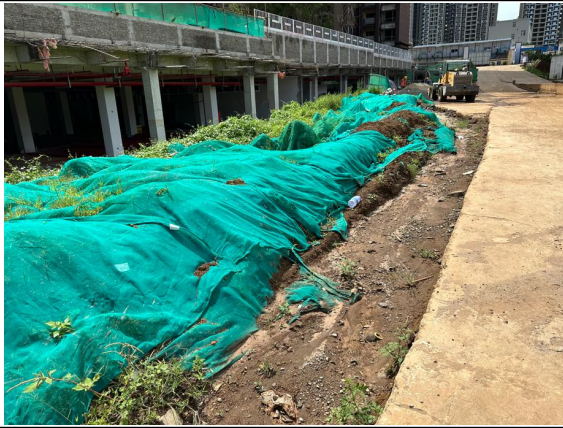
图 8 项目区临时覆盖 2023.06
