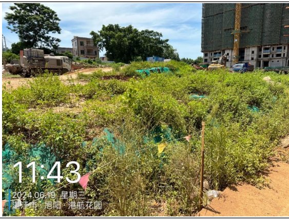
图 12 临时堆土区临时覆盖、绿化 2024.06
