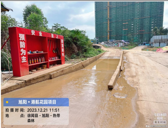
图 10 洗车池、沉沙池 2023.12
