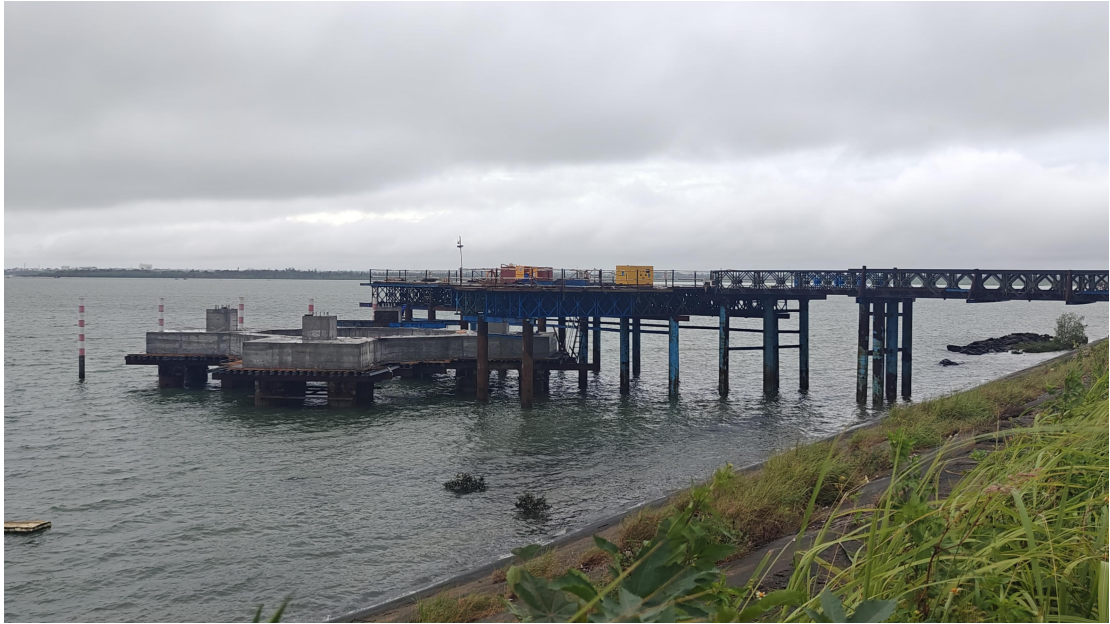
图 1.7-1 项目建设现场照片（施工栈桥平台与塔基基础）
