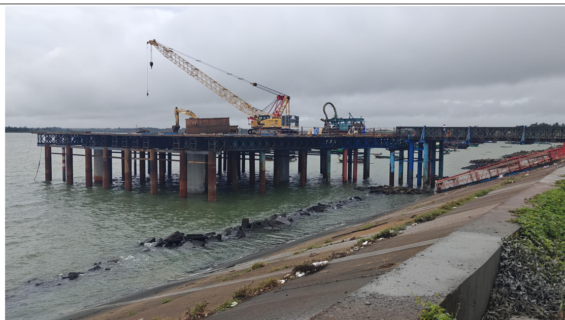
图 1.7-2 项目建设现场照片（施工作业）
