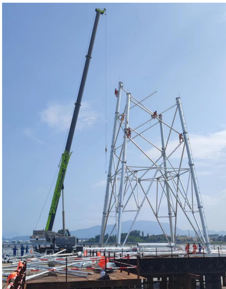
图 1.9.1-6 杆塔吊装
