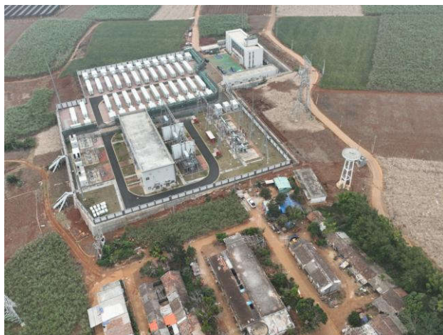
图 14 升压站及农场道路还扩建区现状
