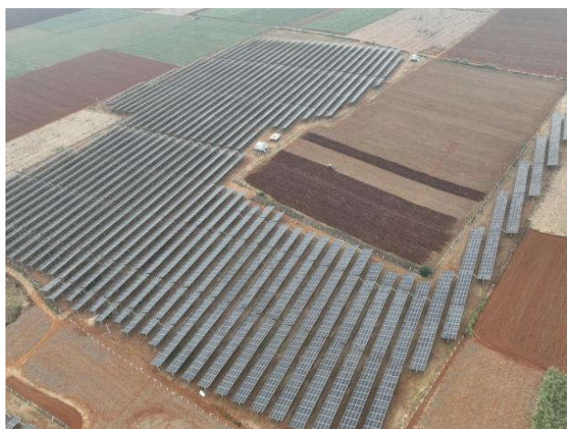
图 6 航拍光伏阵列区现状
