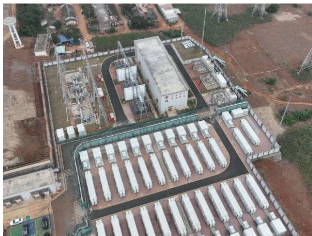
图 16 升压站内绿化及道路硬化现状
