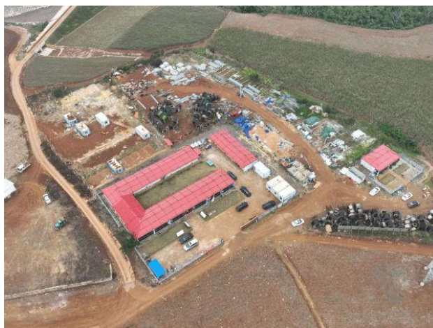
图 24 施工营造区现状
