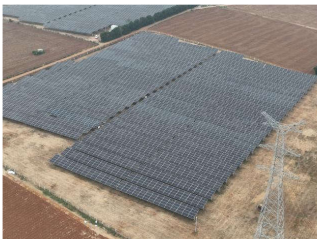
图 5 航拍线路塔基区、光伏阵列区现状
