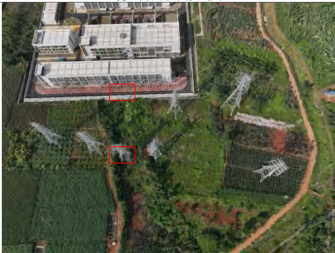
对侧绿能站扩建间隔及 P1 塔基绿化
