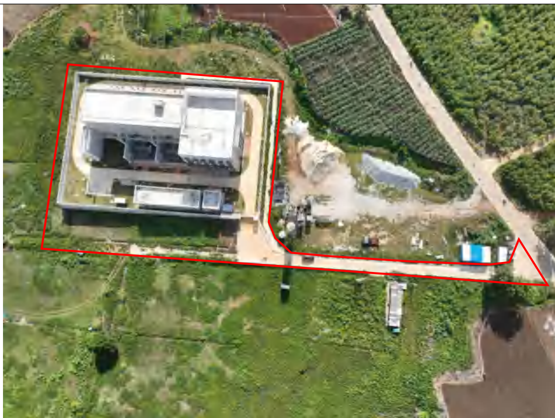
变电站和进站道路
