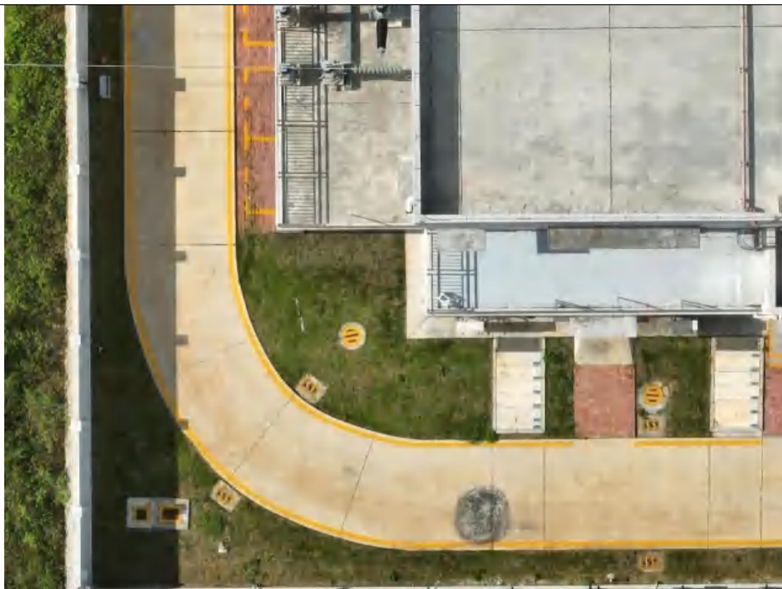
变电站内绿化和排水暗沟
