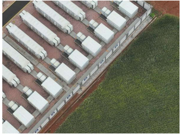
图 20 升压站场外排水沟
