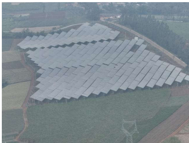
图 2 航拍光伏阵列区现状
