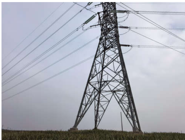
图 11 线路塔基区现状
