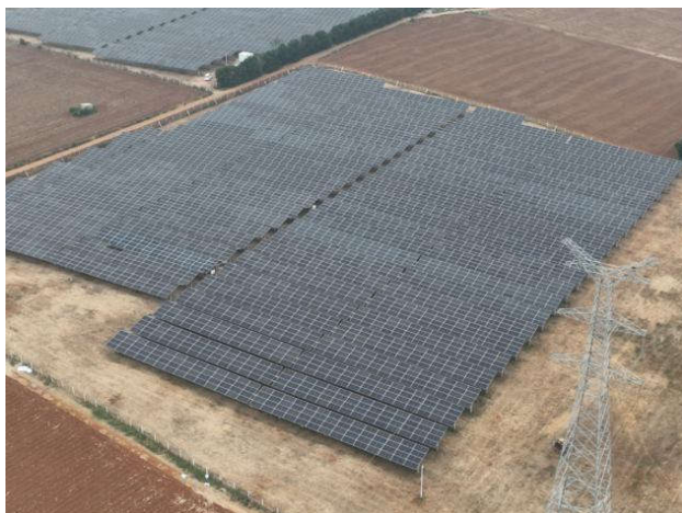
图 5 航拍线路塔基区、光伏阵列区现状
