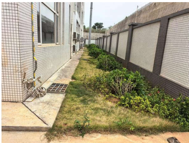
图 17 升压站内绿化
