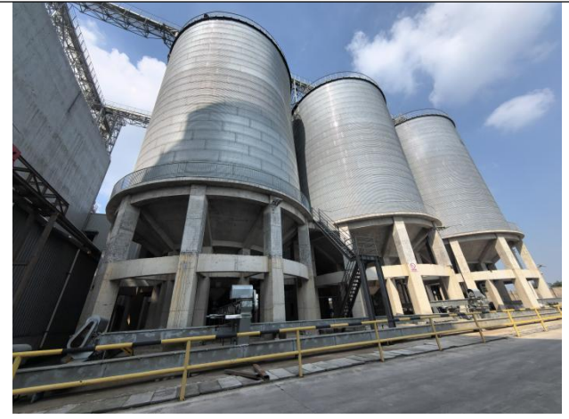
厂区内部-筒仓
