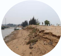
4 自然岸线侵蚀严重
