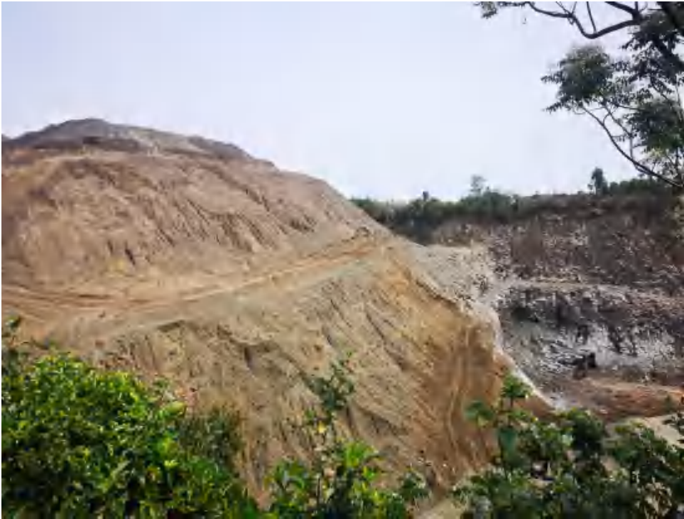
图4-1 堆放场地现状堆填土方
