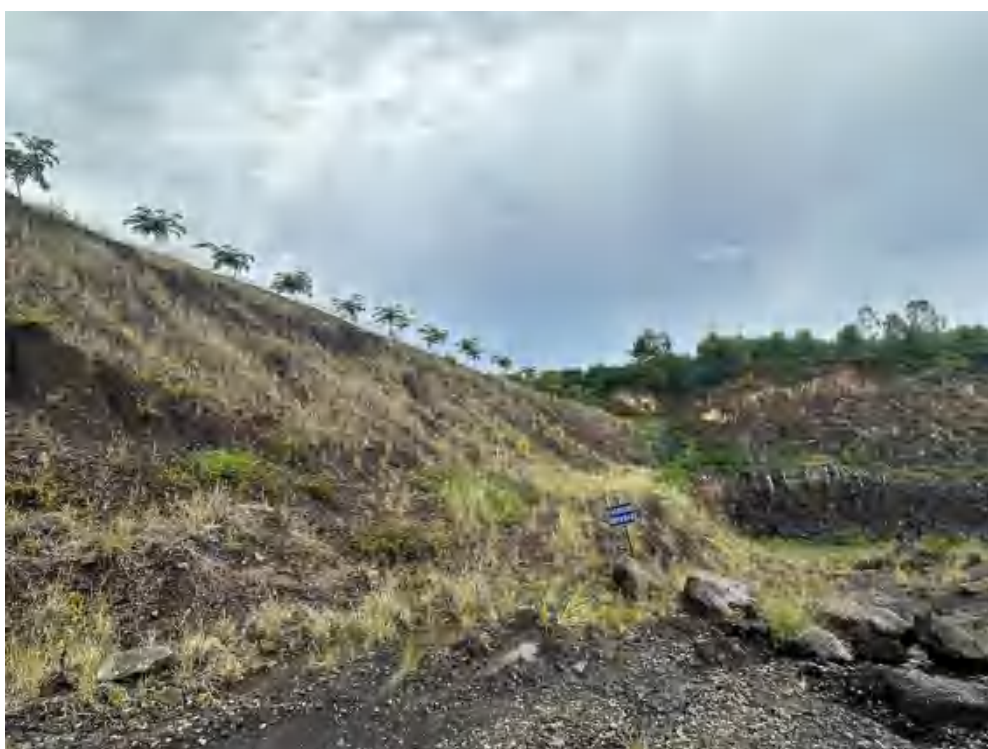
图 1-14 整改后的堆放场地高陡边坡
