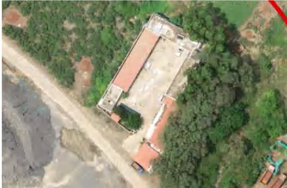
图 1-8 现状综合服务区
