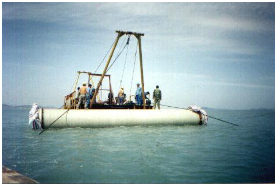
图 2.4-6 玻璃钢管浮运图
