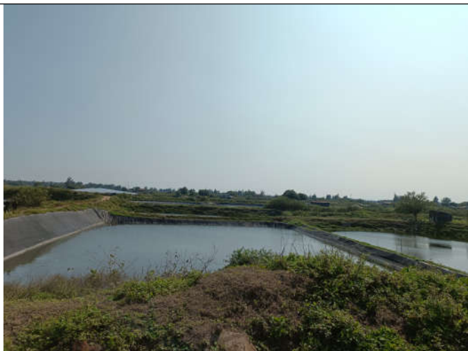
光伏场区北侧边界
