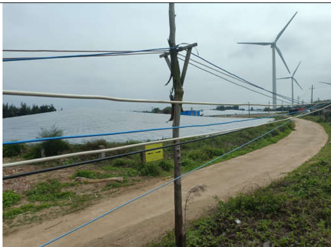
光伏场区东侧边界
