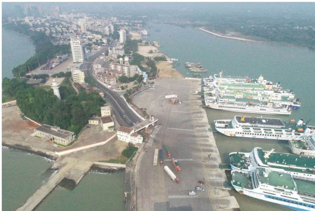
图 2.1.3-2a 项目现场照片 1
